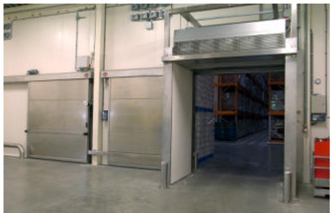
*Der Tiefkühlhaus-Luftschleier realisiert eine gute Klimatrennung*
